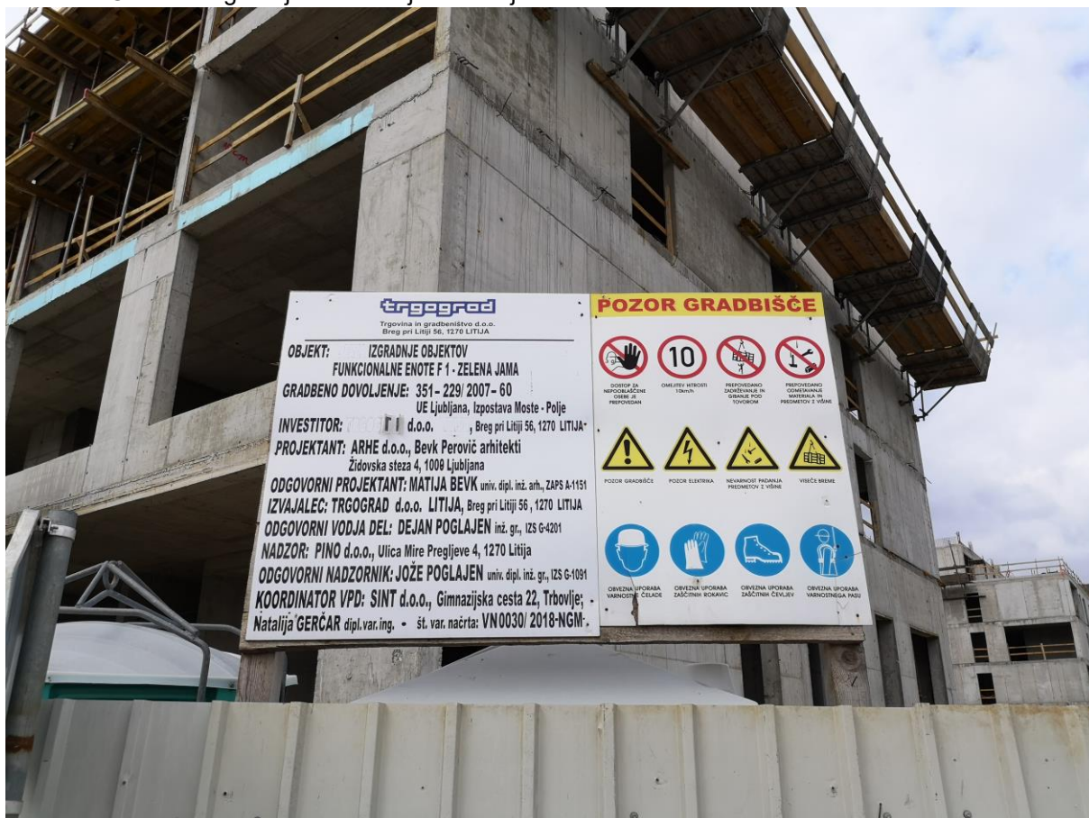
SLIKA 1: Gradbišče gradnje stanovanj v Zeleni jami
